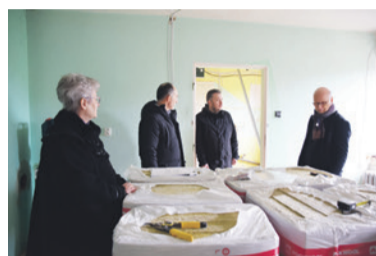
Omówienie prac remontowych na placu budowy
