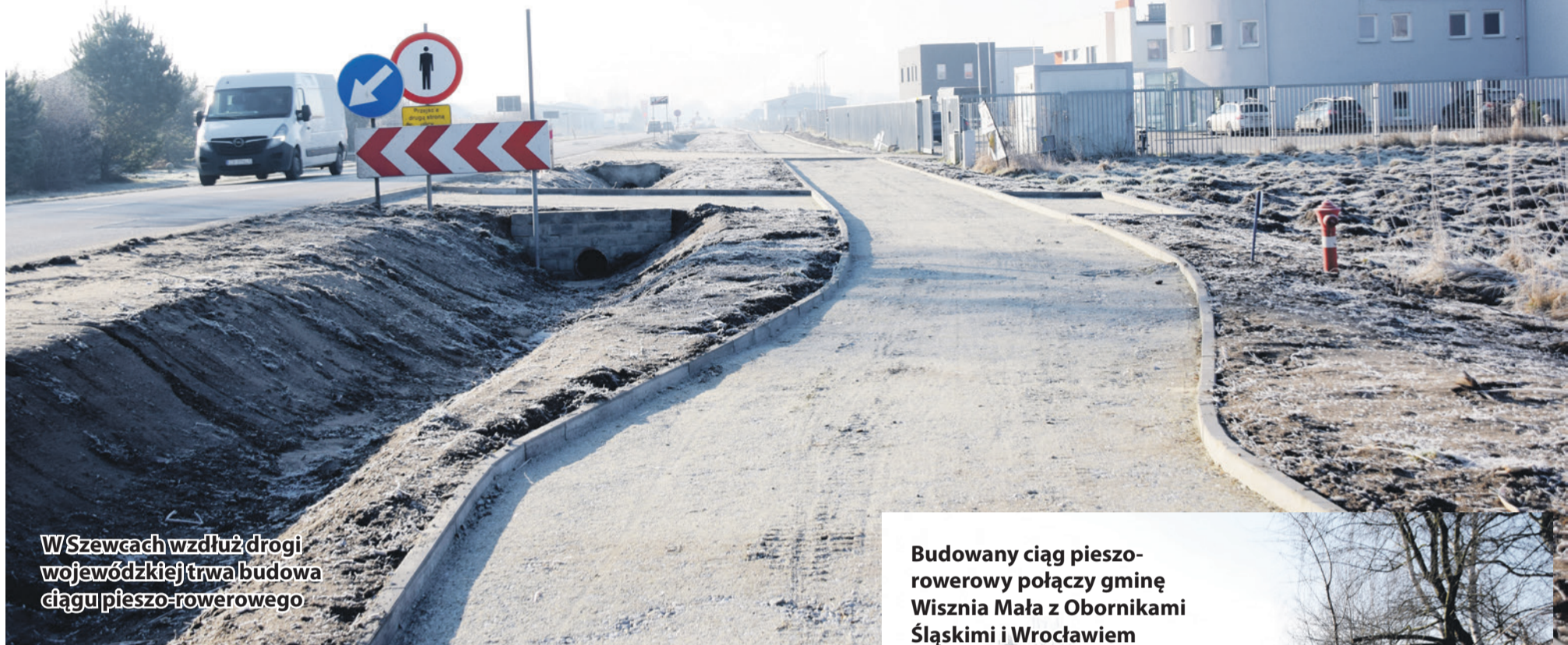
W Szewcach trwa budowa parkingu Park&Ride
