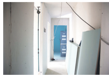
Jedno z remontowanych mieszkań w Piotrkowiczkach
