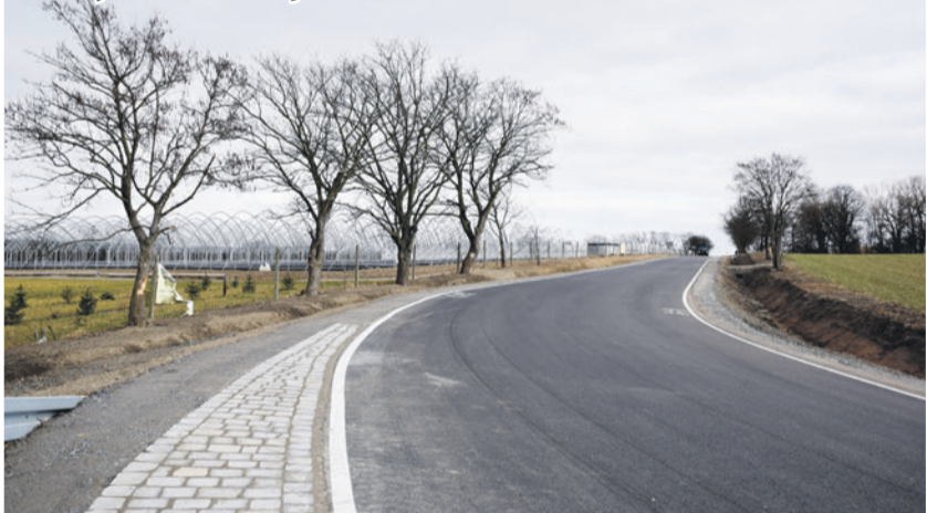
Nowa nawierzchnia na drodze od Strzeszowa do skrzyżowania ze zjazdem do Ozorowic
