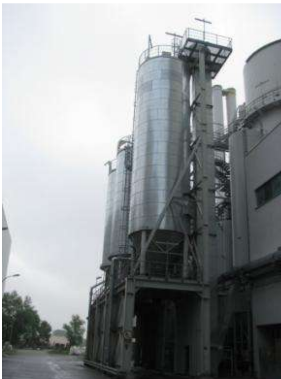
Rysunek 18: Silosy przejazdowe na pozostałości poprocesowe.
